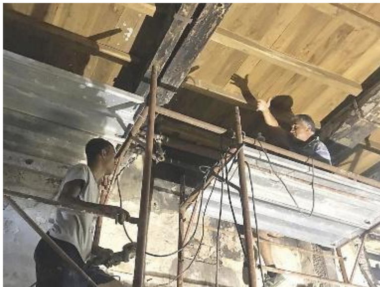
Un momento dei lavori: un patrimonio da custodire
