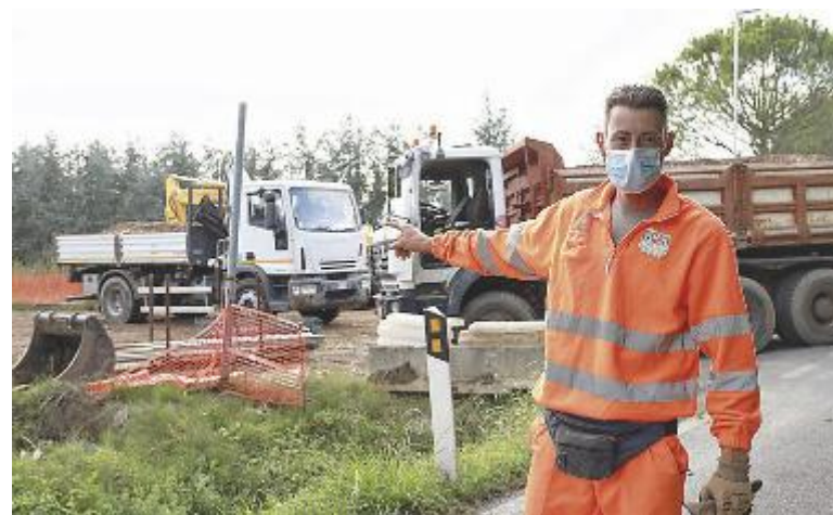
Operai a lavoro nel cantiere per la costruzione della rotonda del Tiro a Volo a Massa e Cozzile (foto Goiorani)
