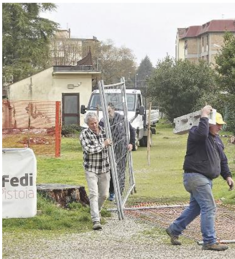
I lavori all'impianto erano iniziati nel mese di febbraio. Dal 20 giugno partiranno quelli per la pista di atletica (foto archivio Castellani)
